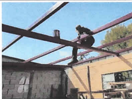
Foto 3: Sustitución de techo
